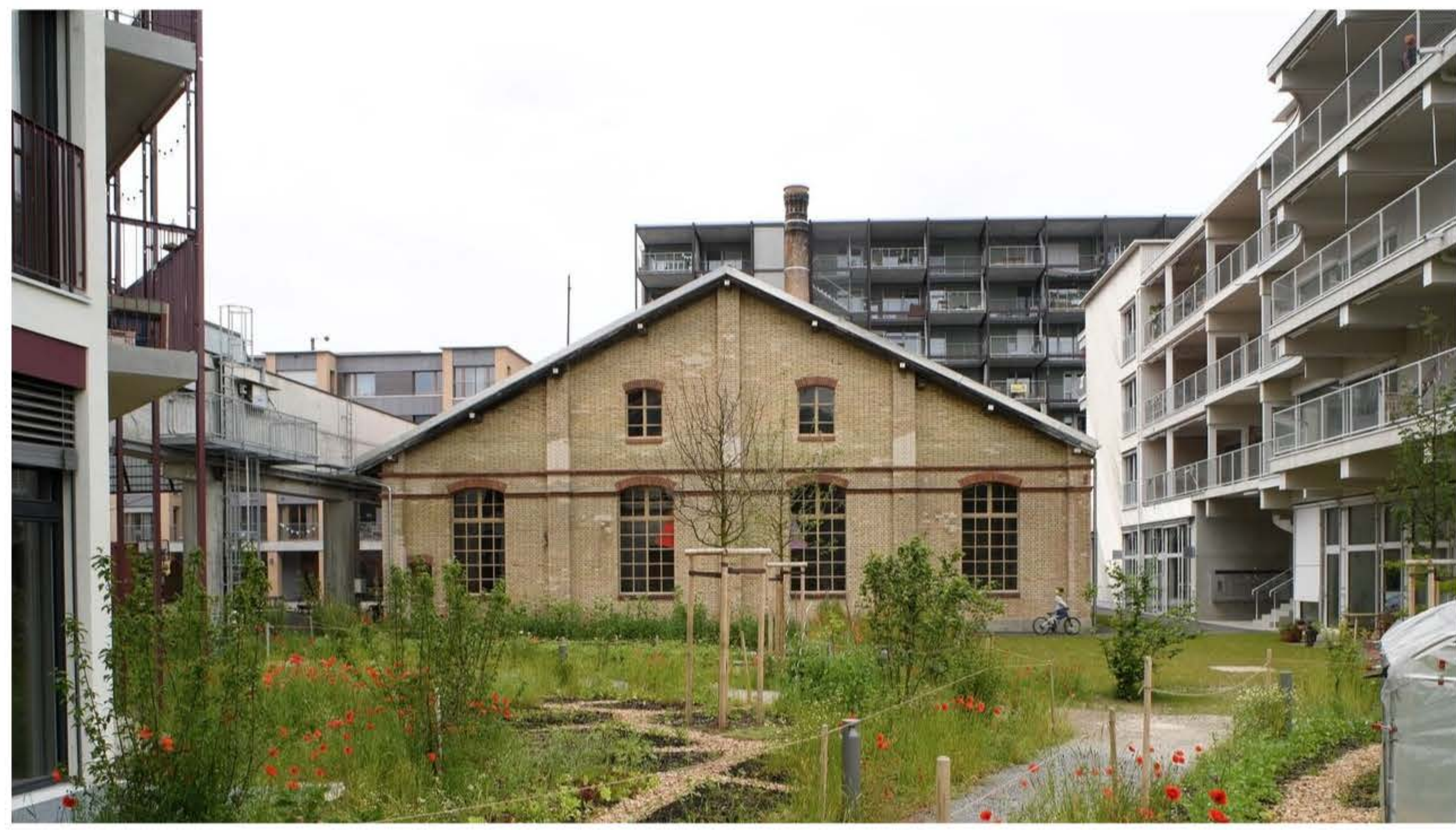
Site du Hobelwerk, Winterthur © Christian Flierl
