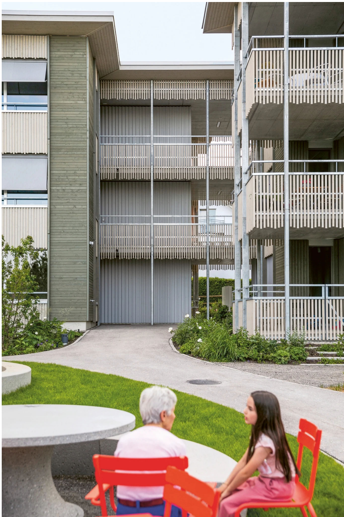
Der Grünraum der Siedlung mit Spielplatz und Sitzmöglichkeiten steht auch den Quartierbewohnerinnen offen.
