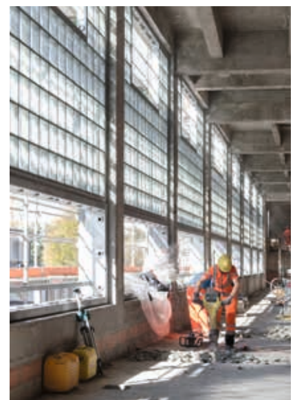
3 Schon die Baustelle vermittelt einen Eindruck der zukünftigen Wohnatmosphäre. Le chantier donne un aperçu de l'atmosphère des futurs logements. Il cantiere dà già un'idea della futura atmosfera degli alloggi.
