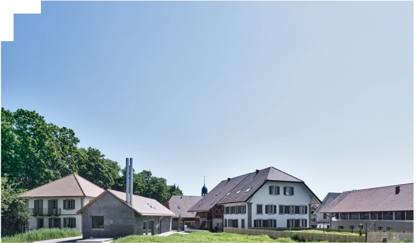
In Cressier haben LVPH Architectes ein stimmiges Ensemble geknüpft: das alte Schulhaus (1), das Gemeinschaftshaus (5), das grosse Bauernhaus (6) und der ehemalige Schweinestall (7). Fotos: Rolf Siegenthaler
